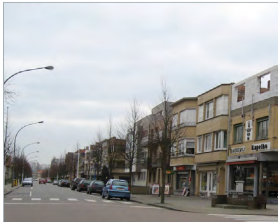
Strandlaan ter hoogte van de E. Bertrandlaan. Compacte gesloten bebouwing veelal bestaande uit meer-gezinshuizen van 3 bouwlagen hoog. Weinig kleinhandel aanwezig.
