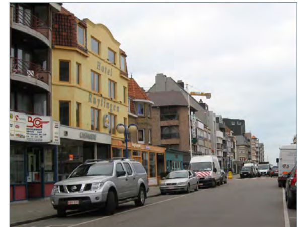
Strandlaan ter hoogte van de J. Dillenslaan. Compacte gesloten bebouwing veelal bestaande uit 3 tot 5 bouwlagen hoog. Op het gelijkvloers kleinhandel aanwezig.
